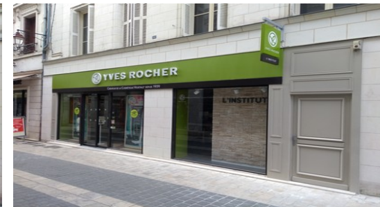
Devanture commerciale après travaux, création d'un accès indépendant aux étages
